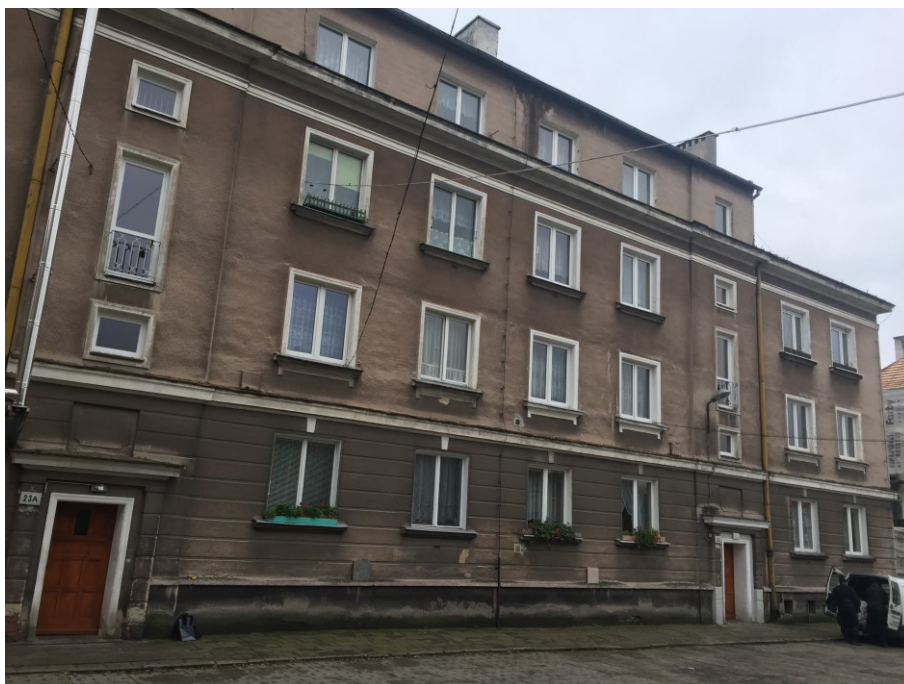
Fot. 1 Elewacja północna
